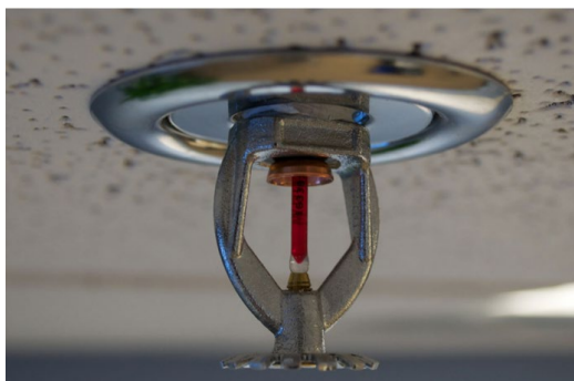
Figur 2-2: Sprinklerdysse med varmeaktivert glassbulb. Foto: RISE Fire Research.
